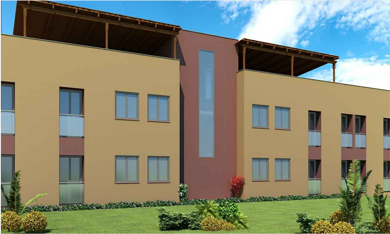
VISTA FACHADA POSTERIOR
