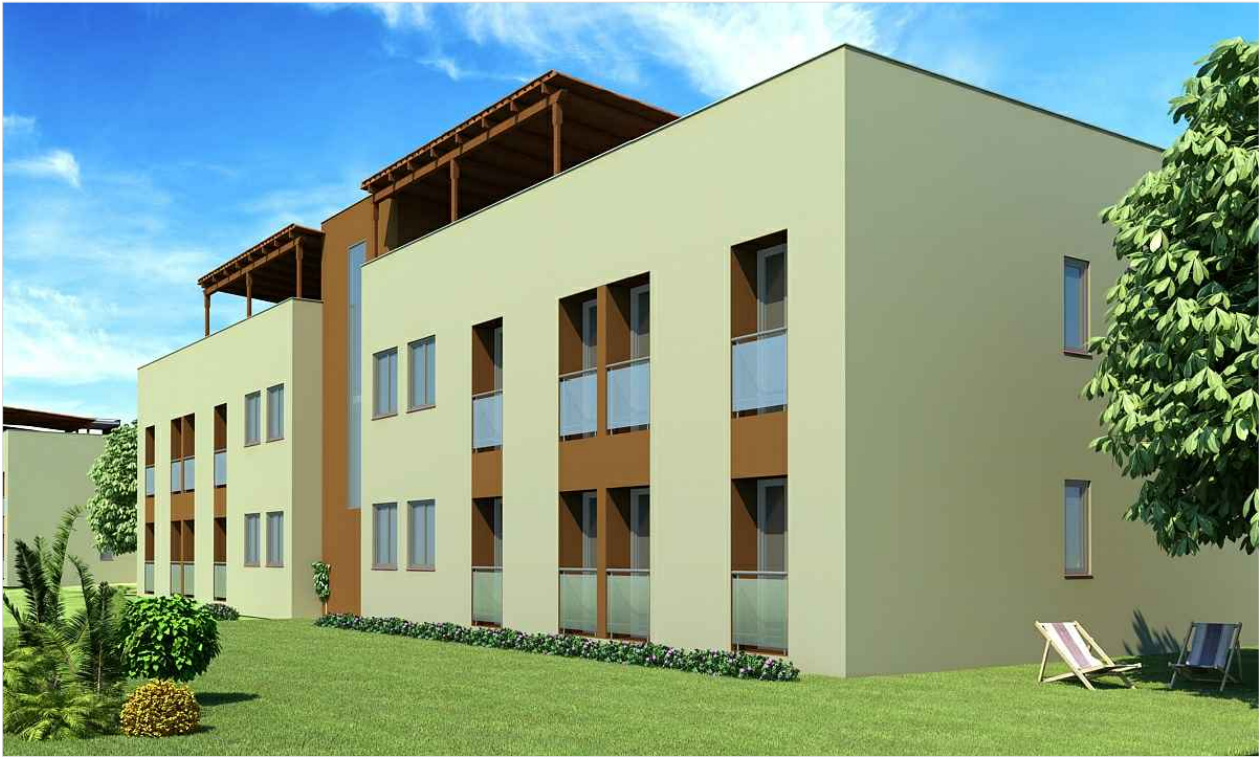
VISTA FACHADA POSTERIOR
