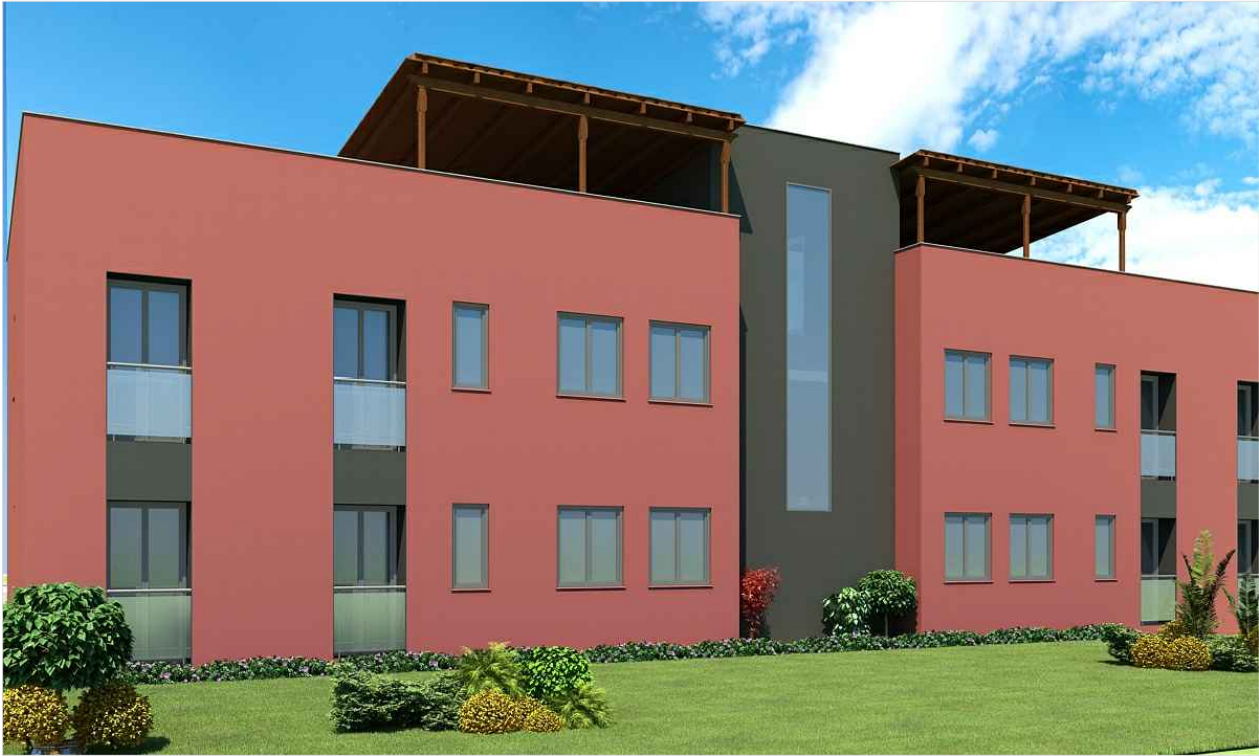
VISTA FACHADA POSTERIOR
